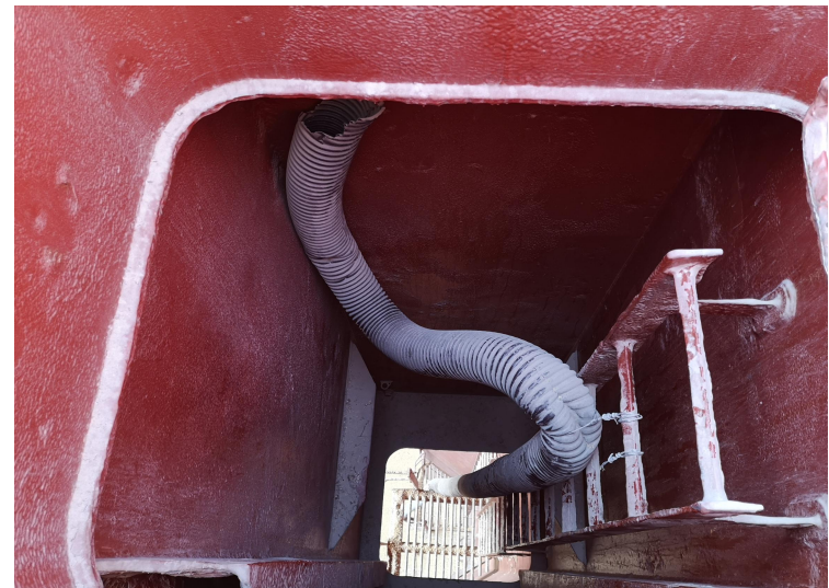
• 波纹管引向舱内
